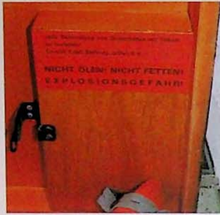
Öle und andere leicht entflammare Stoffe dürfen nicht mit Sauerstoff in Verbindung gebracht werden, da Brandgefahr besteht.
